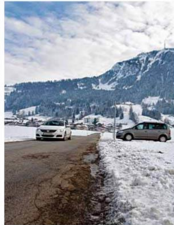
Viele Schäden weist die Straße zwischen Goymoosmühle und Wagneritz (hinten) auf. Darum will sie die Gemeinde Rettenberg auf Vordermann bringen. Foto: Klaus Kiesel
